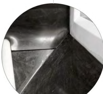
Vnitřní prostory bez lemů pro rychlé čištění
